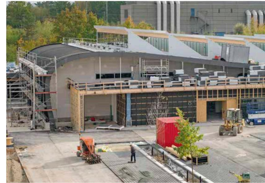
der Festigkeitsklassen 14/24 GL24h bzw. 18/32 GL24h, deren Seiten und Schrägen von BSP-Elementen gebildet werden, die die Lasten in die waagrecht liegenden Dachflächen ableiten. Die eigentliche geschwungene Dachform der Entwurfsplanung wird von sechs in Längsrichtung an der nördlichen Giebelwand platzierten BSH-Bogenbindern gebildet. Die
